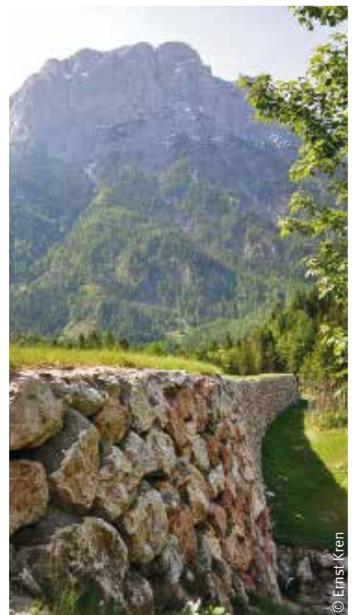
2 imposante Erscheinungen aus gleichem Material – die Planspitze und der Lawinenablenkdamm
